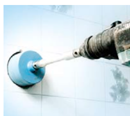
Kernbohrung in der Wand
